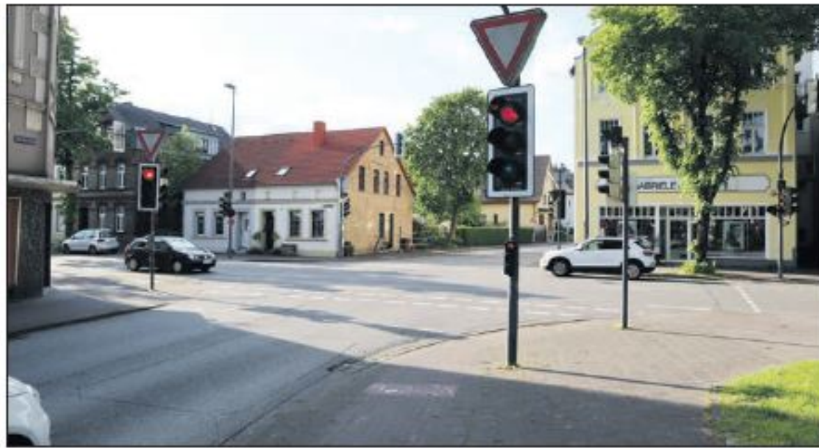
Gefahrenpunkt an der Kreuzung von Bastionstraße und Beckumer Straße: Für die Radlerinnen und Radler bleiben nur zu schmale Spuren. Foto: Karl-Heinz Tiemann
